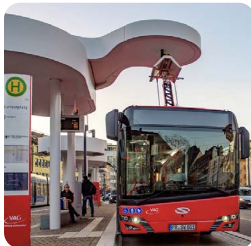
Pantografová stanica integrovaná v prestrešení zastávky v nabíjacia meste Freiburg (Zdroj: Freiburger Verkehrs)
