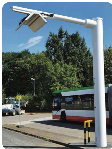
Pantografová stanica na konečnej zastávke v jednoduchšom industriálnom dizajne
