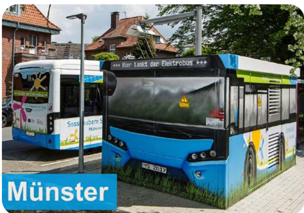
Príklad inštalácie trafostanice v bezprostrednej blízkosti nabíjacej stanice v meste Münster (Zdroj: Stadtwerke Münster)
